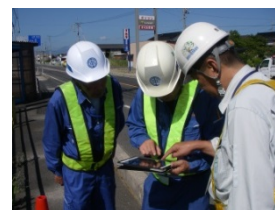
現場管理へのタブレット活用
